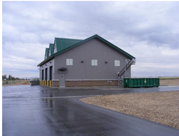
Kuna, ID WWTP
